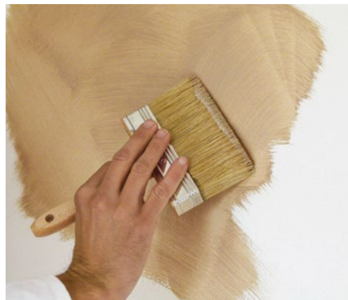
Nanášanie náteru – použite 3 × 12 cm štetec s prírodnými štetinami
