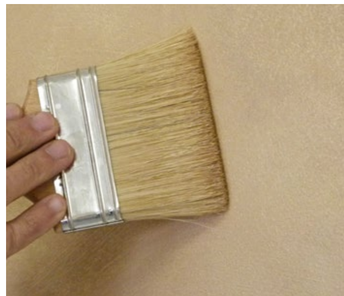
Na vyhladenie povrchu – použite 1,5 × 10 cm štetec s prírodnými štetinami
