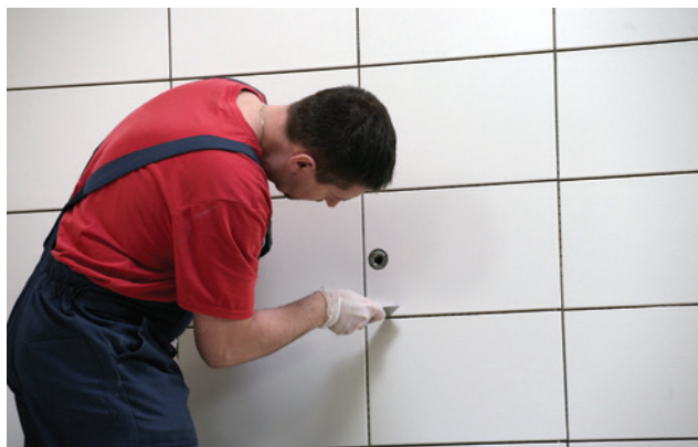
Vyčistenie škár a okrajov obkladov od zvyškov lepidla.
